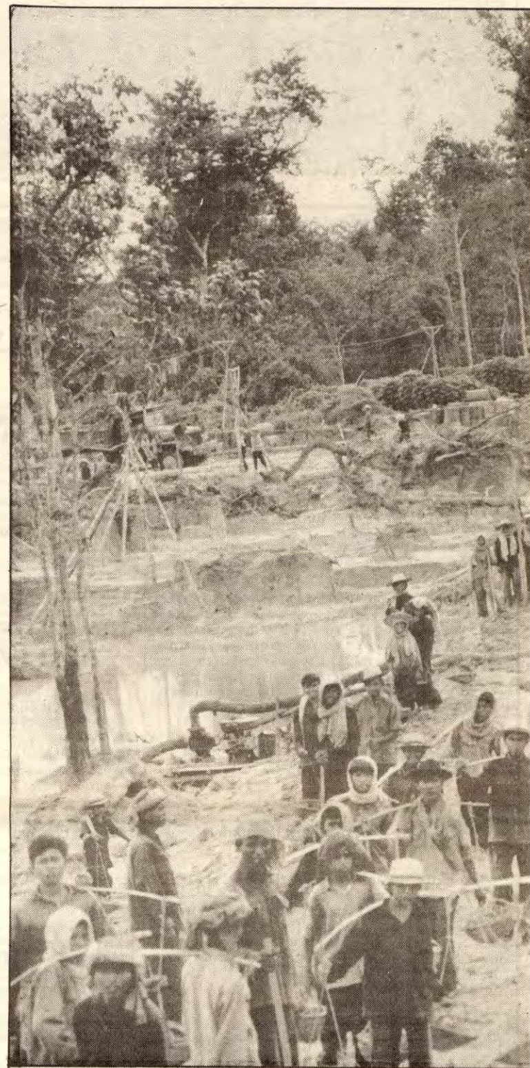
I Kampong Thom-provinsen arbeider 3 000 kampucheanere fra hele landet for å bygge en vanningskanal. De har
