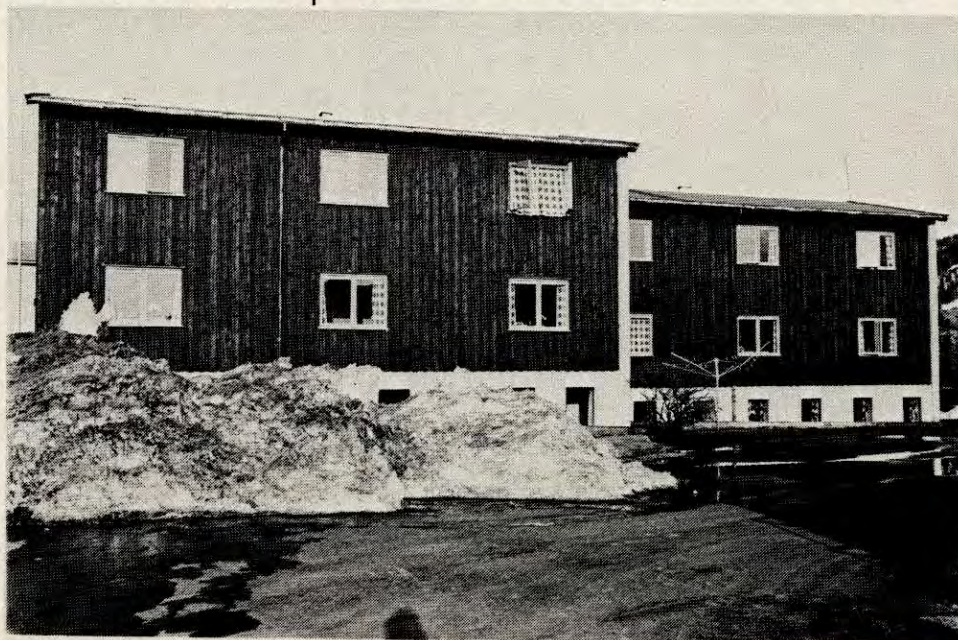
Hybelhuset i Mo i Rana som skal rives
