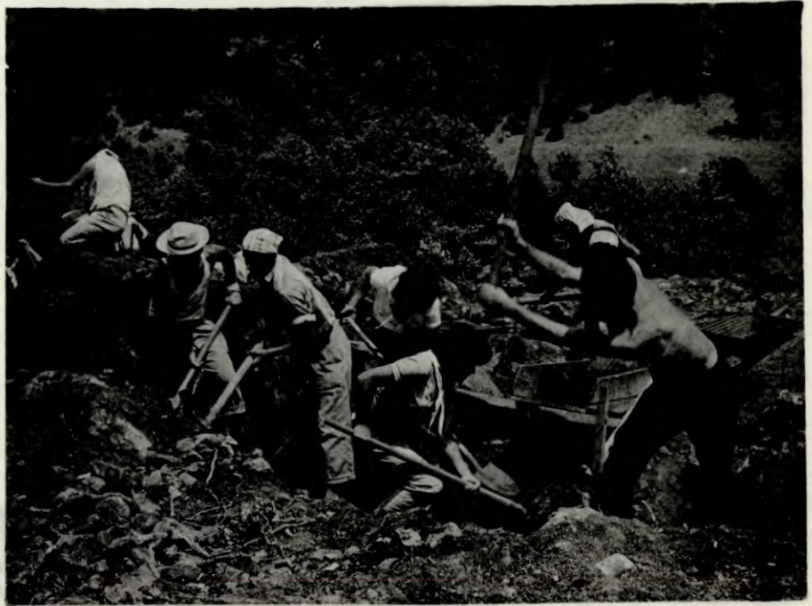
Albansk ungdom deltar i oppbygginga av landet sitt, her med bygging av en ny jernbane.
