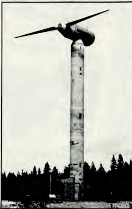
Vindkraft kan bli et brukbart tilskudd til andre energikilder. Her fra et forsøksanlegg ved Alvarleby i Sverige.
