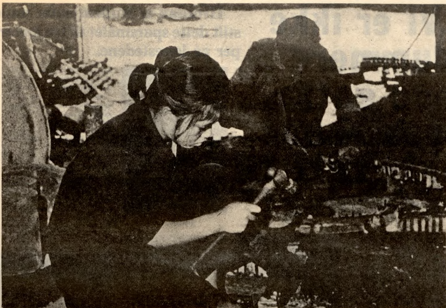
Etter den sosialistiske revolusjonen i Kina har kvinnene fått full rett til arbeid. Det omfatter også arbeid i yrker som vanligvis betraktes som «mannsarbeid». Her ser vi kvinner ansatt i bygge- og anleggsbransjen i arbeid i Peking.
