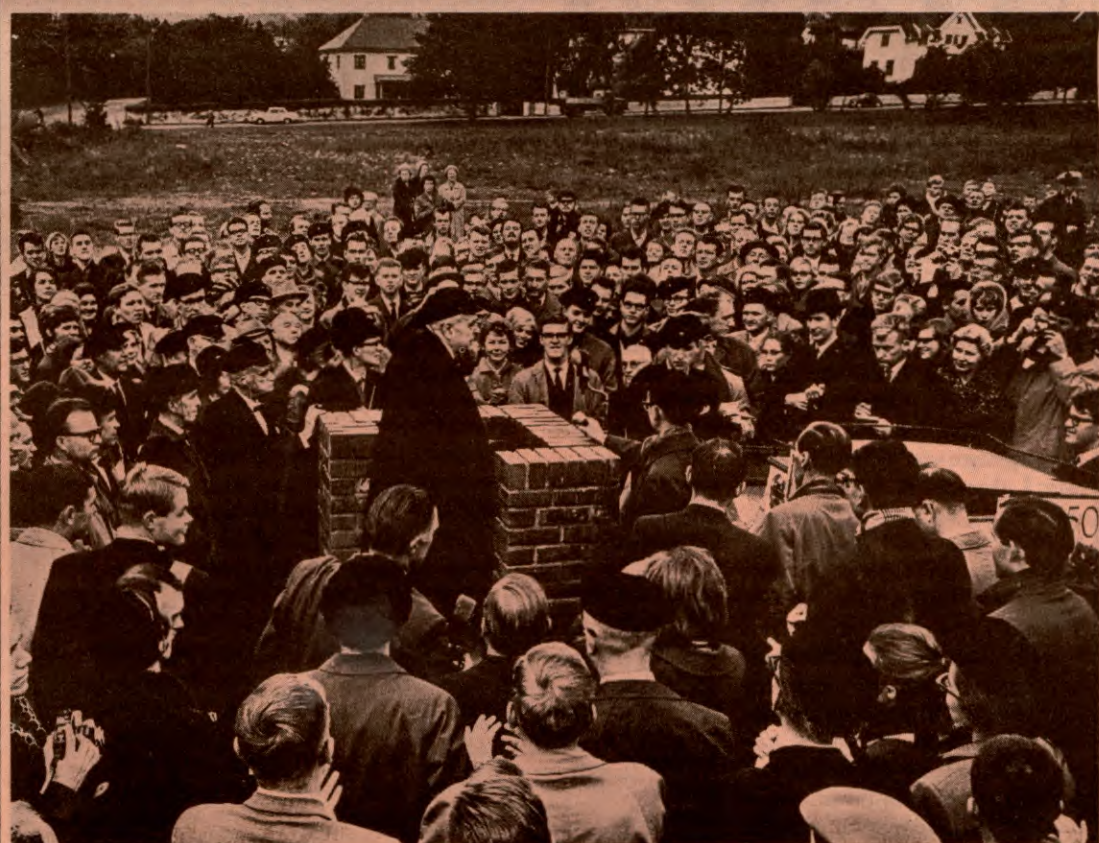
C.J. Hambro legger ned grunnsteinen i 1963. Det er illustrerende for «planlegginga» at grunnsteinen i dag ligger utafor Huset!
